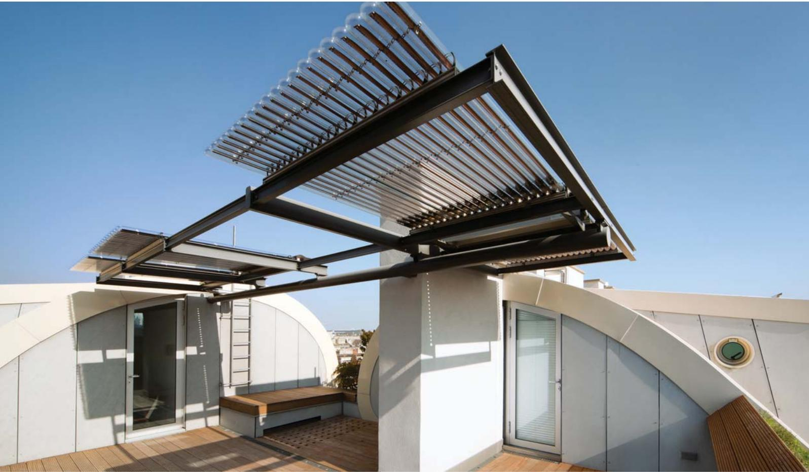
Vakuum-Röhrenkollektoren können lageunabhängig montiert werden und eignen sich beim Neubau auch sehr gut als architektonische Elemente.
