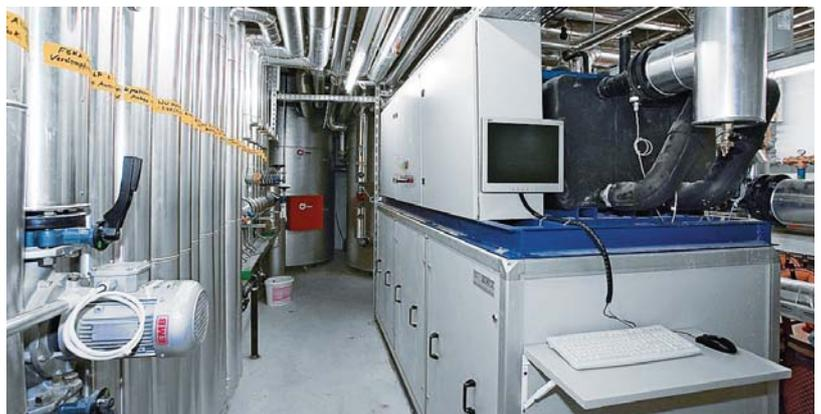
Eine Abwasser-Wärmepumpe mit 150 kW Leistung für die Trinkwassererwärmung
