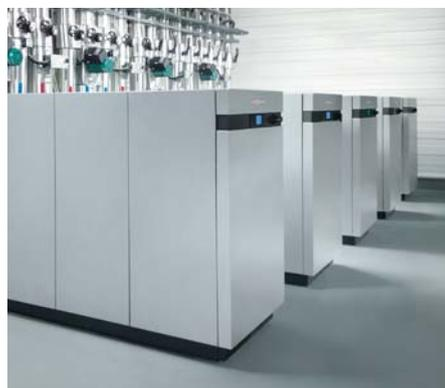
Technikraum in Manisa (Türkei) mit fünf Vitocal 300-G Pro Wärmepumpen zur Gebäudeklimatisierung
