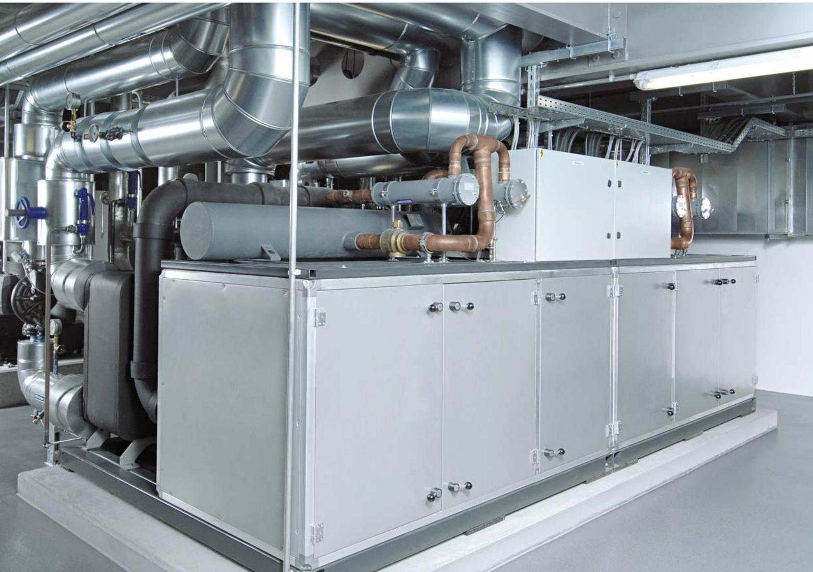
Diese Wärmepumpe nutzt die Abwärme und kühlt gleichzeitig das Rechenzentrum sowie die Geräteprüfstände am Viessmann Standort Allendorf
