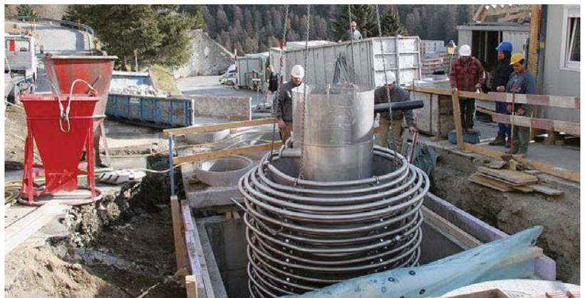
Dieser Abwasserschacht dient als Primärquelle zur Warmwasseraufbereitung.
