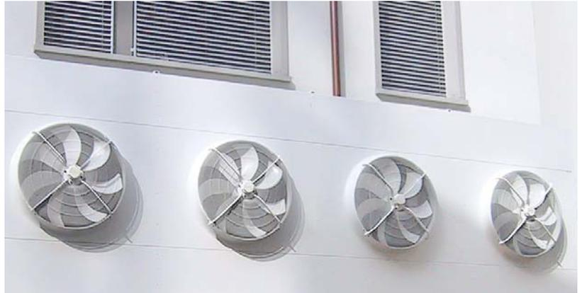
Glykol-Rückkühler als integrierte Fassadenlösung für Luft/Wasser-Wärmepumpen
